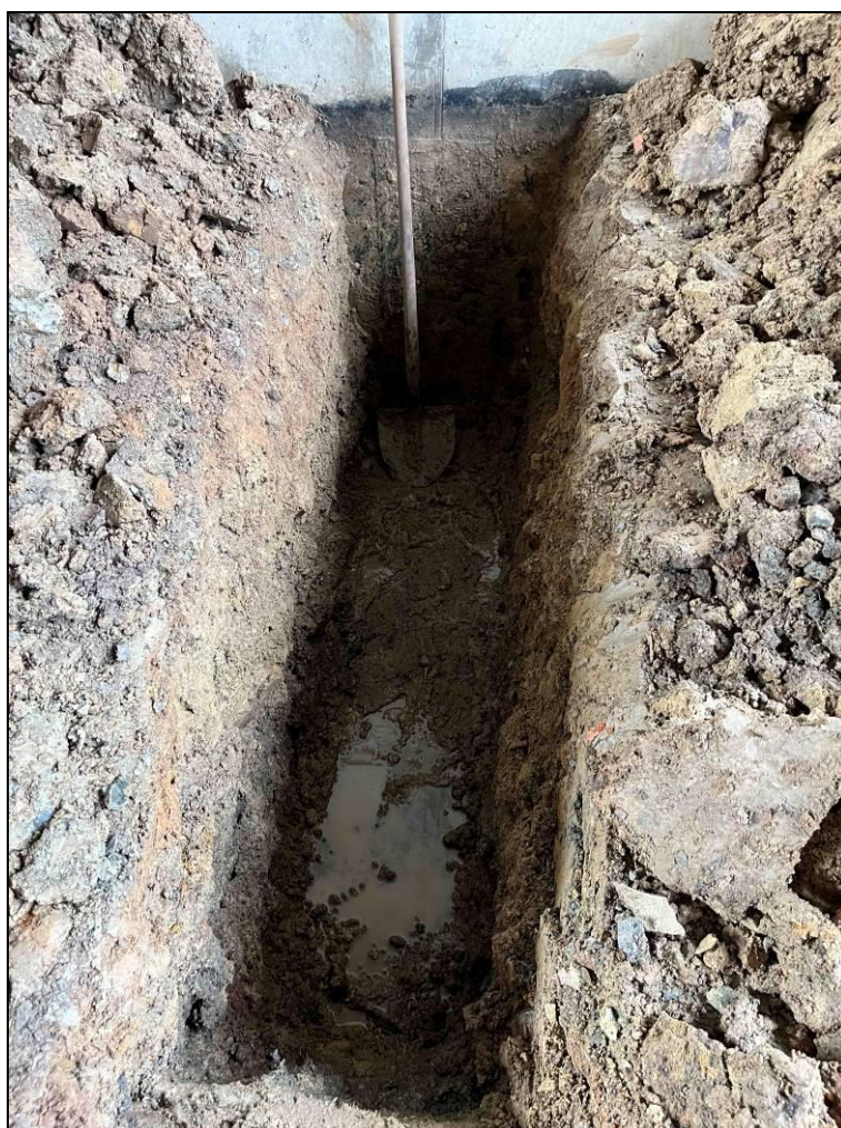
Obr. č. 4 – kopaná sonda KSM1 a odhalený základový odstupek
